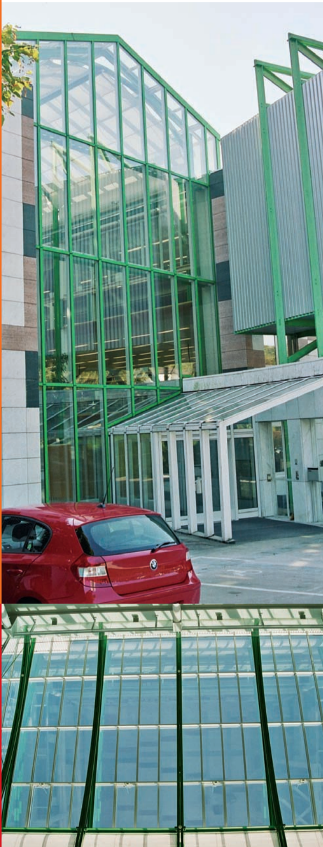
MGTherm Heat Mirror Dachverglasung Bürogebäude HM 44, U_g = 0,6 \text{ W/m}^2\text{K} , g = 26\%
