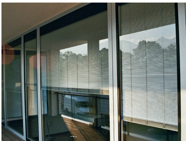
MGTherm Heat Mirror Isolierglas mit integrierter Jalousie – shadow star für zusätzlichen Sonnen- und Blendschutz sowie Sichtschutz (Einfamilienwohnhaus)
