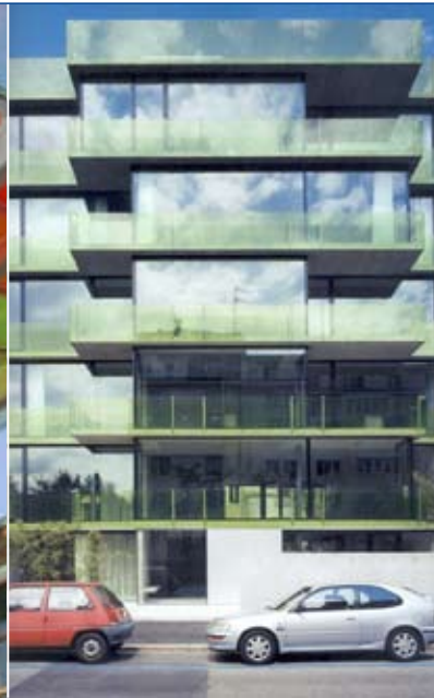
Geländerverglasung Wohnhaus Basel
