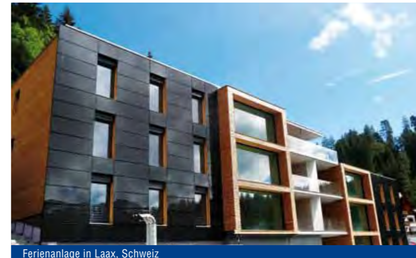
Ferienanlage in Laax, Schweiz
